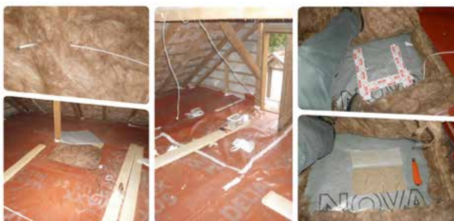
2. ábra: Hígrotermikus monitoring rendszer kialakítása a hajdúnánási hőszigetelt családi ház padlásfödémének hőszigetelésében
