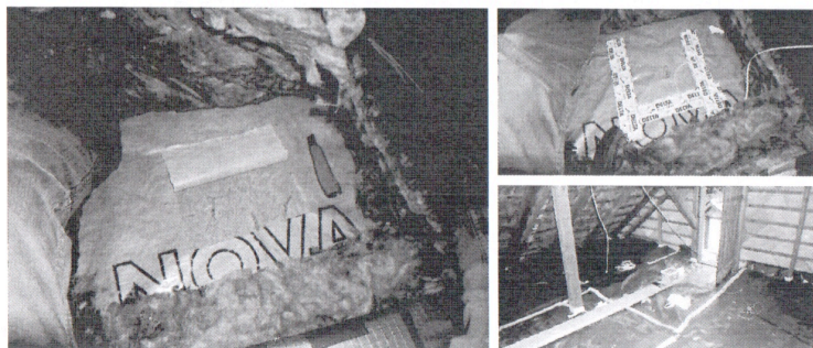
7. ábra Födémhőszigetelés készítése és monitoring pontok elhelyezése
