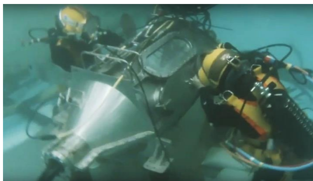
Ipari búvárok javítanak egy tengeri kommunikációs kábelt egy speciális túlnyomásos kamra segítségével, melybe behúzták a sérült kábel két végét. Ez a javítási megoldás ritkább és csak sekélyebb vizekben használható a búvárok miatt.
