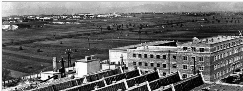
A Szilas-patak az AURAS-ból nézve az Ikarusz felé. A jobb oldali épület tetején látszik a „helyénmaradó őrs” (óvófülke) is. Háttérben, a távolban a budai hegyek. (KHEK)
