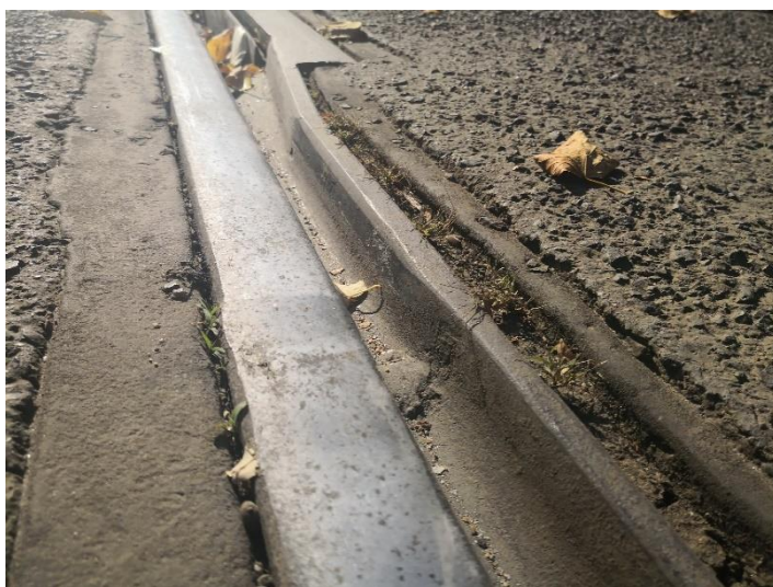
51. ábra: A Clark Ádám téri vonali visszafogás használatból eredő avulási jelenségeinek elhelyezkedése [45]
