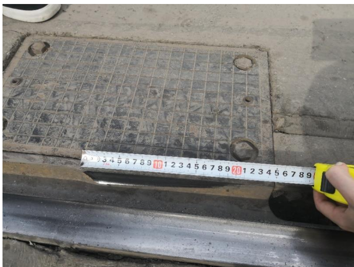
50. ábra: Az Etele út/Fehérvári út végállomás vágánykapcsolatának hibahelyei [45]
