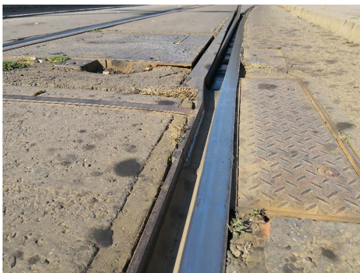
52. ábra: A Döbrentei téri pályaelágazás használatból eredő avulási jelenségeinek elhelyezkedése [45]
