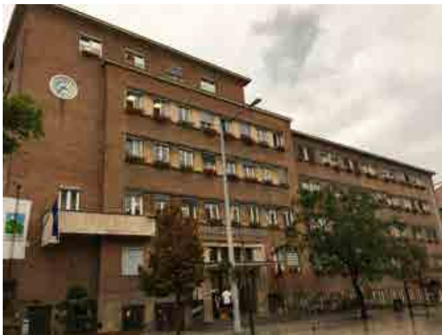
1. ábra. Az önkormányzati épület utcaképe
