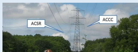
Fig.2 – Hagyományos ACSR és egy magas hőmérsékletű alacsony belógású ACCC sodrony belógás összehasonlítása [2]
