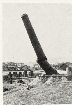
Chute d'une cheminée haute de 63 mètres. Bâtisseur de Londres.
