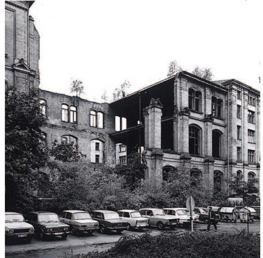
a felújítás előtti állapot
