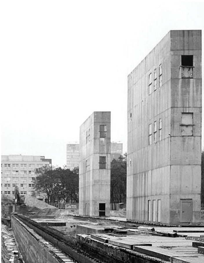
Zumthor féle terv építés közben
