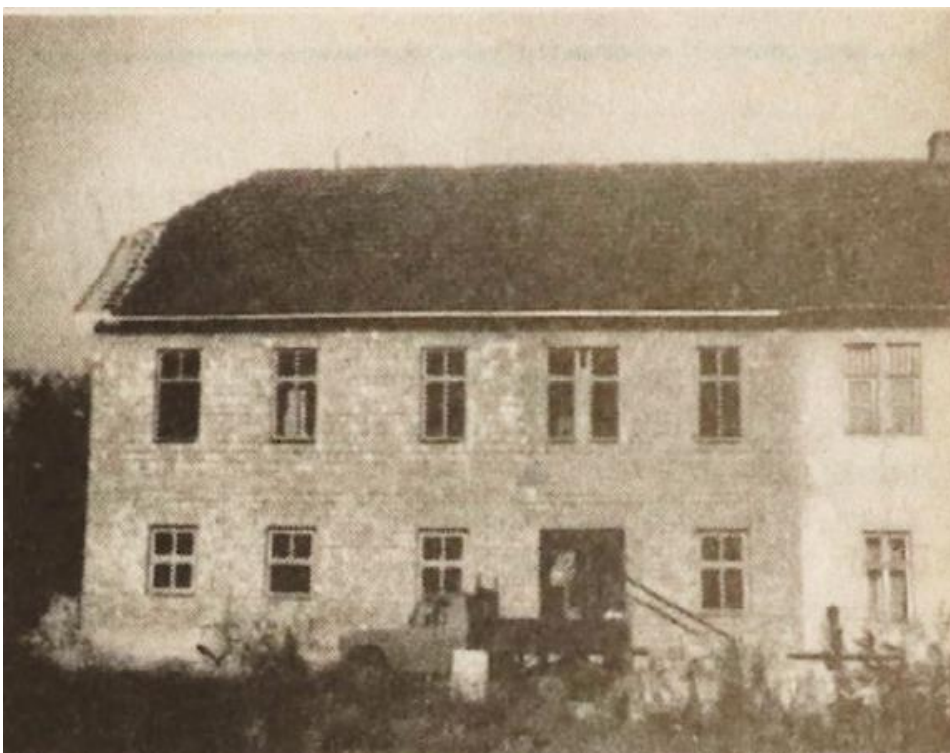
10. kép: Az Otthon épülő új szárnya (1990)
