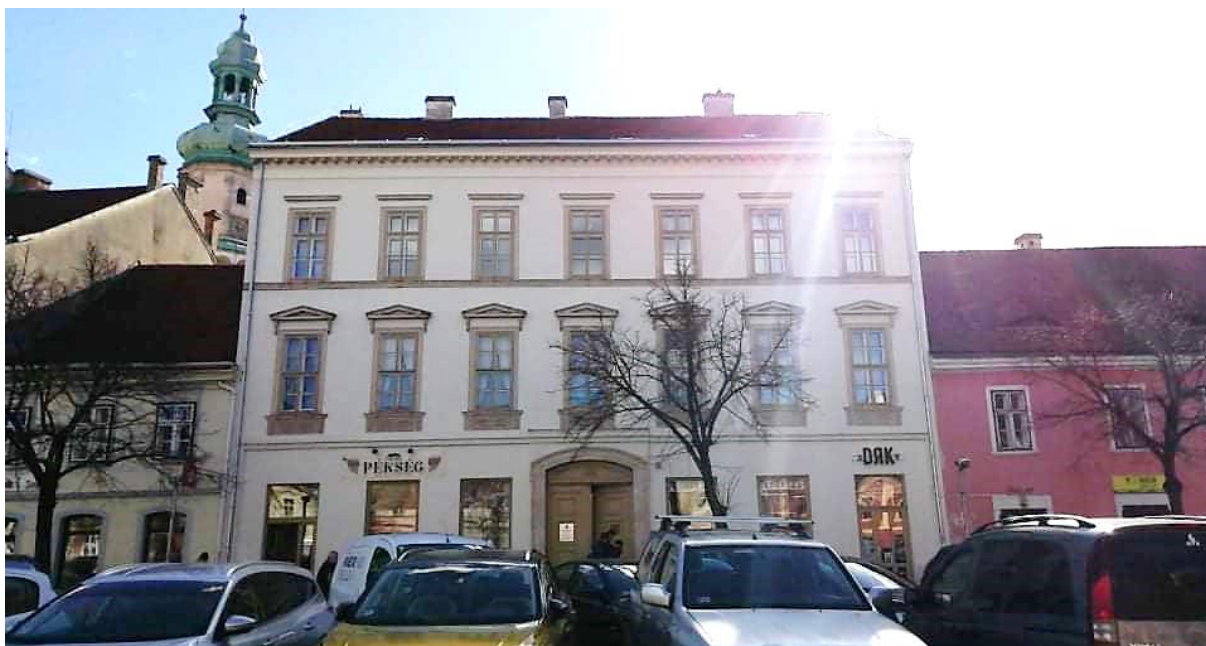
A Petrik család Várkerület 9. (jelenleg 10.) szám alatti kétemeletes háza Sopronban (Fotó: Gál Gergely, 2022)
