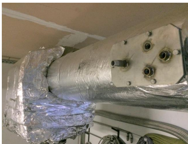
Obr. 2 Příruba pro odběr spalín
