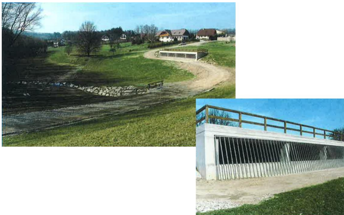
Photo 5 Flood control reservoir Mausbach (Source: Amt der Steiermärkischen Landesregierung 1999)
