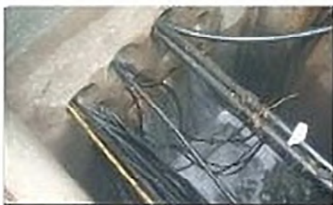
6-12. ábra: Fotó a kábelaknába történő szivárgásról (balra); az akna állapota a szivárgás megszüntetése (betonnal feltöltés) után (jobbra) [6.3]
