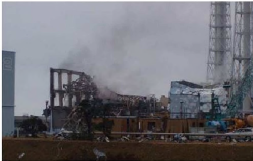
6-4. ábra: A 3. blokk épülete a robbanás után [6.2]
