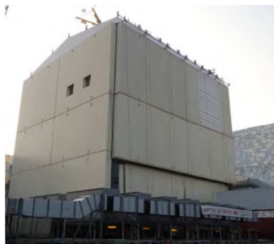
6-15. ábra: Az 1. blokkra felhúzott védőépület [6.18]
