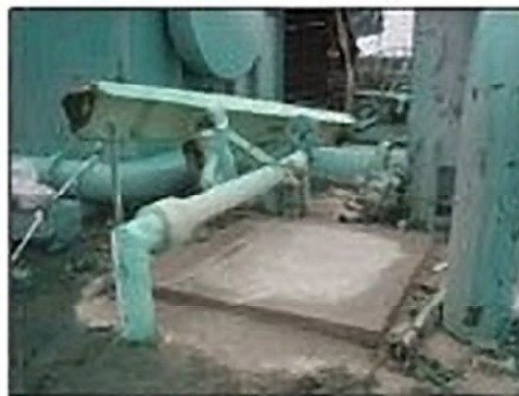
6-12. ábra: Fotó a kábelaknába történő szivárgásról (balra); az akna állapota a szivárgás megszüntetése (betonnal feltöltés) után (jobbra) [6.3]
